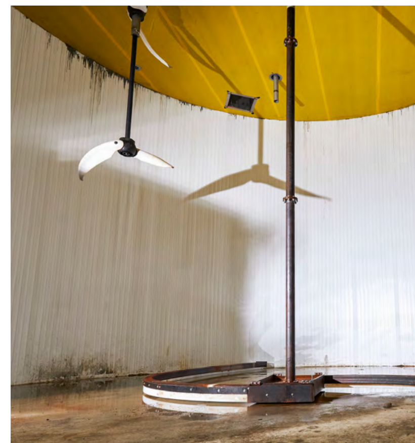
Agitateur et balayeuse à l'intérieur du système de digestion auto-nettoyant de ZooShare
