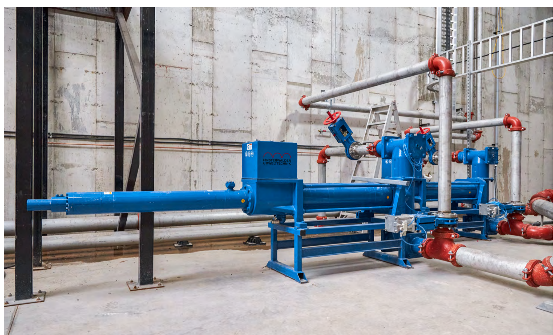
POMPE KV20 VANNE À BOISSEAU SPHÉRIQUE
